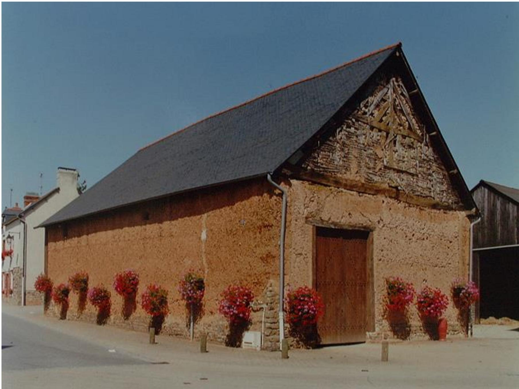
Photographie d'une halle en terre crue et paille (technique de la bauge) à Saint-Sulpice-la-Forêt en Bretagne.
