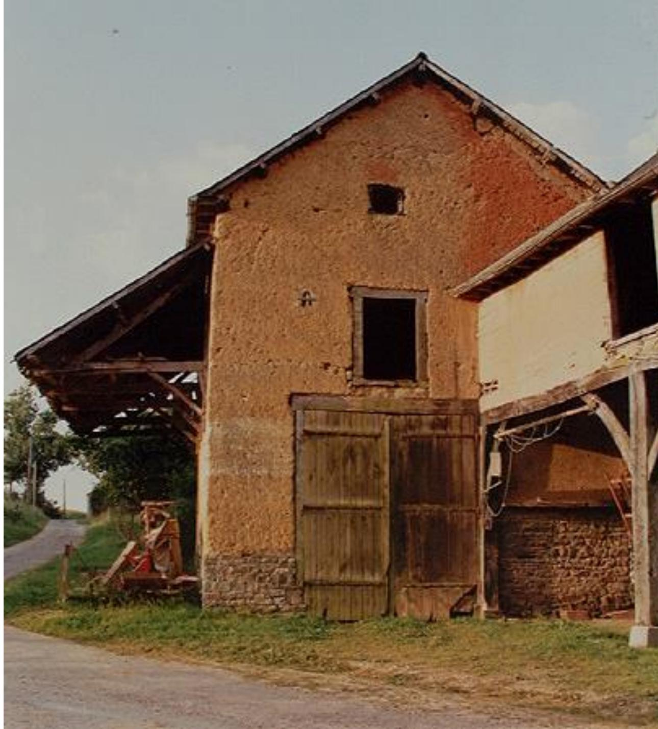
Photographie d'une grange en terre crue et paille (technique de la bauge) à Melesse en Bretagne.
